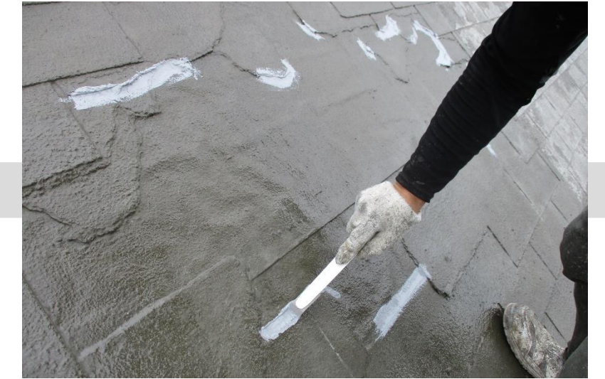
下地調整 (シーリング)
