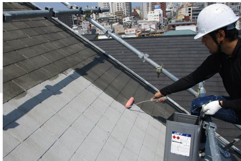
プライマー塗布
