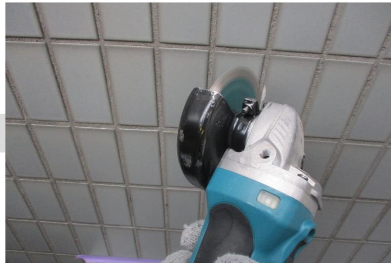
浮き・欠損タイル撤去
