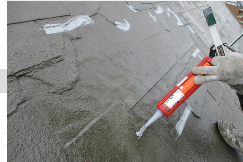
下地調整 (シーリング)
